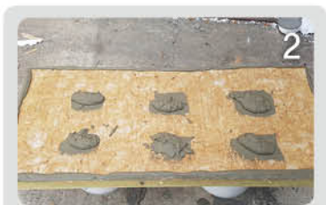
미네랄울 표면강화제를 바른 후 미네랄울 접착제 도포
