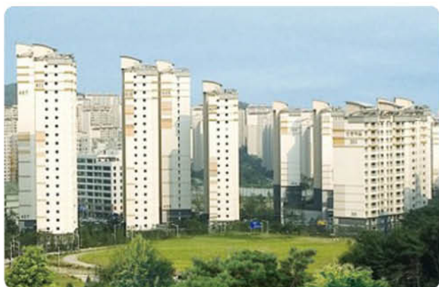
용인신봉 동일하이빌아파트 현장
