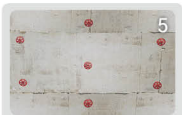
미네랄울 전용 화스너 설치
